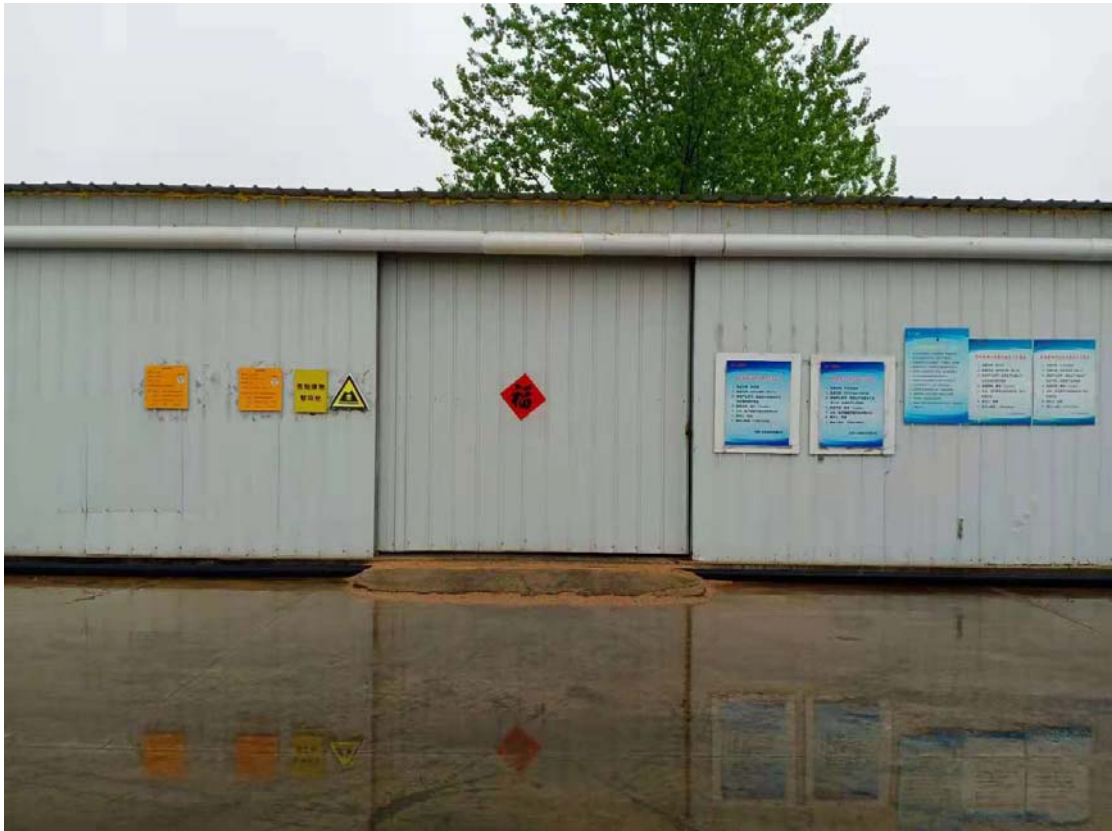
日照广大建筑材料有限公司危废暂存库照片
